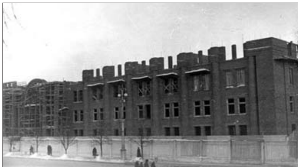
Строительство минского главпочтамта. 1952 год.
